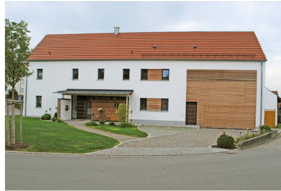
◆ Münsterhausen, Lkr. Günzburg - Ersatzbau für ein-sturzgefährdeten Bauernhof
